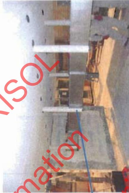
Protection au feu des tiges filetées par collage au plâtre de deux 1/2 coquilles en staff de diamètre 90 mm
